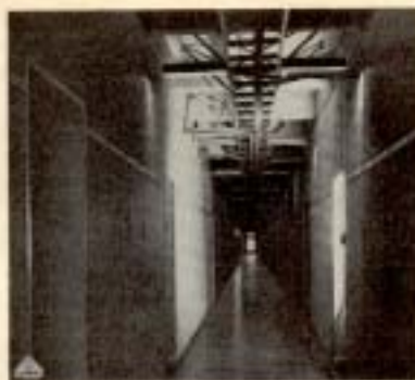
Fig. 9. Tendido de conductores de experimentación.
