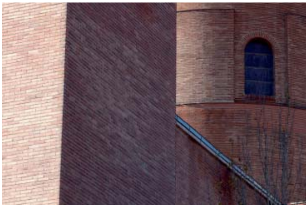
Esquina del edificio del Auditorium y Biblioteca de la Residencia de Estudiantes, donde se puede ver el inicio de la cúpula de la iglesia que construyó en él Fisac (Abel Veldenegro, CSIC)
