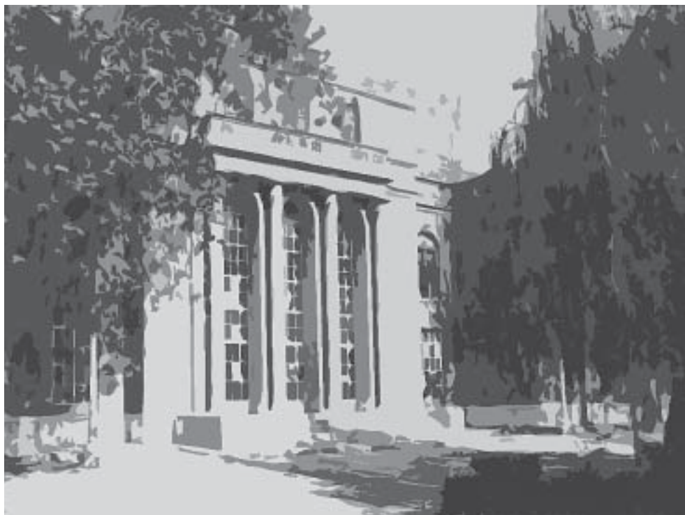
Fachada del edificio Rockefeller (IQFR)
